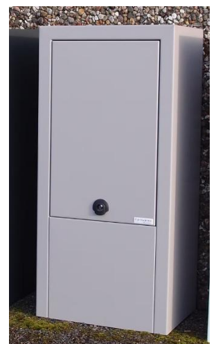
Eksempel på et fjernvarmestikskab. Andre fabrikater kan anvendes.
